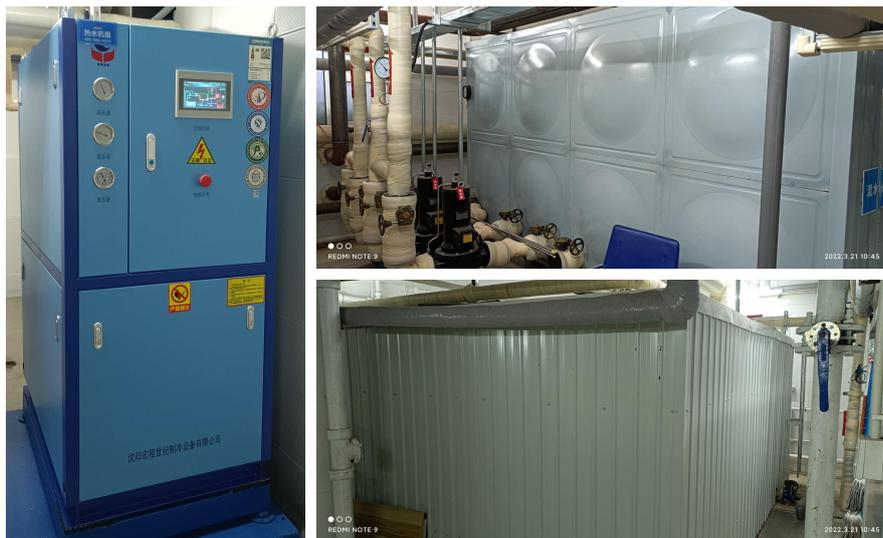
图 4 热泵机组、洗浴热水箱、蓄热污水箱
