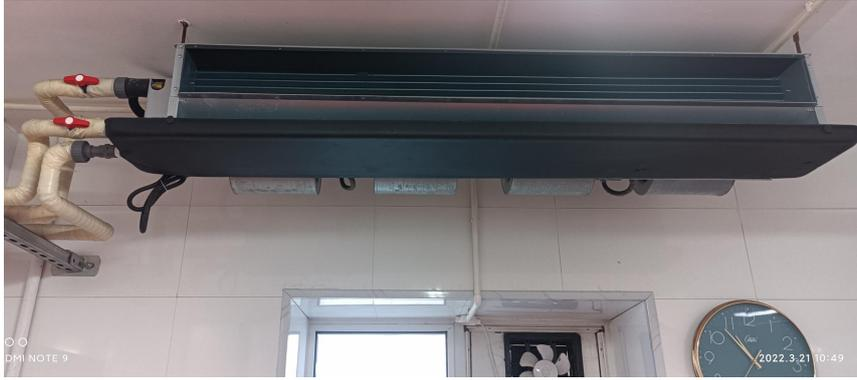
图5 浴室内安装的风机盘管照片
