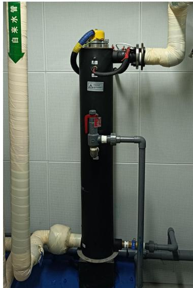
图6 电加热器补热系统
